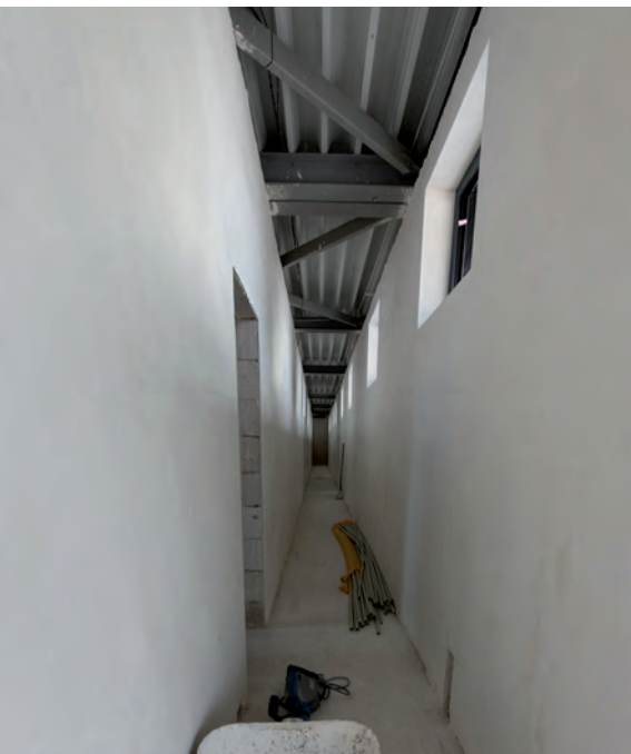
Dlouhá chodba, ze které se vstupuje do šaten
