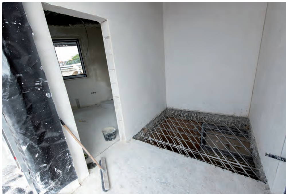
Po odřezání ocelových výztuží vsadí stavaři do otvoru točité schodiště
