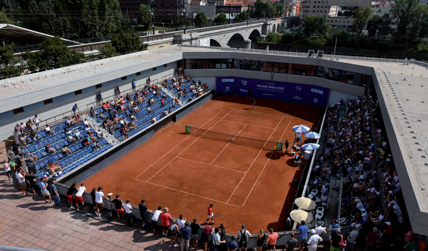
Pohled na dostavěnou podkovu malého centru je opravdu pěkný
