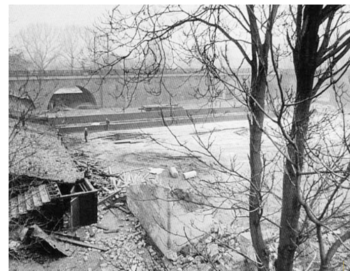
Starý štvanický centrkurt těsně před tím, než začala demolice
