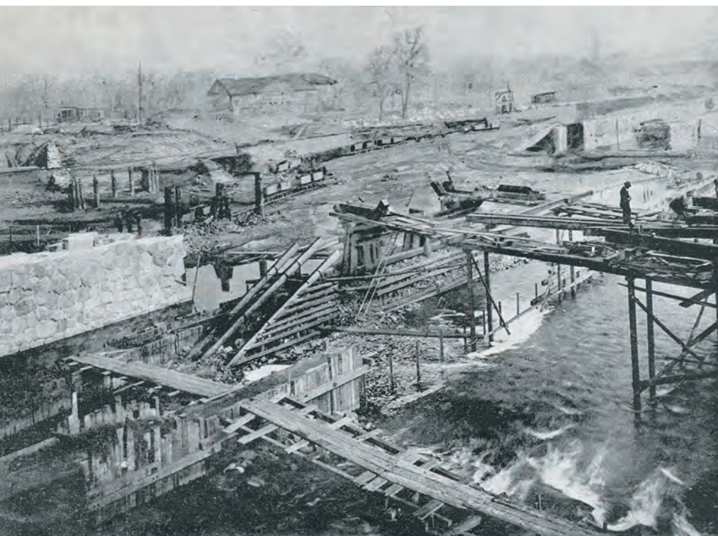
Provádění velkých vodních staveb u ostrova v roce 1910
