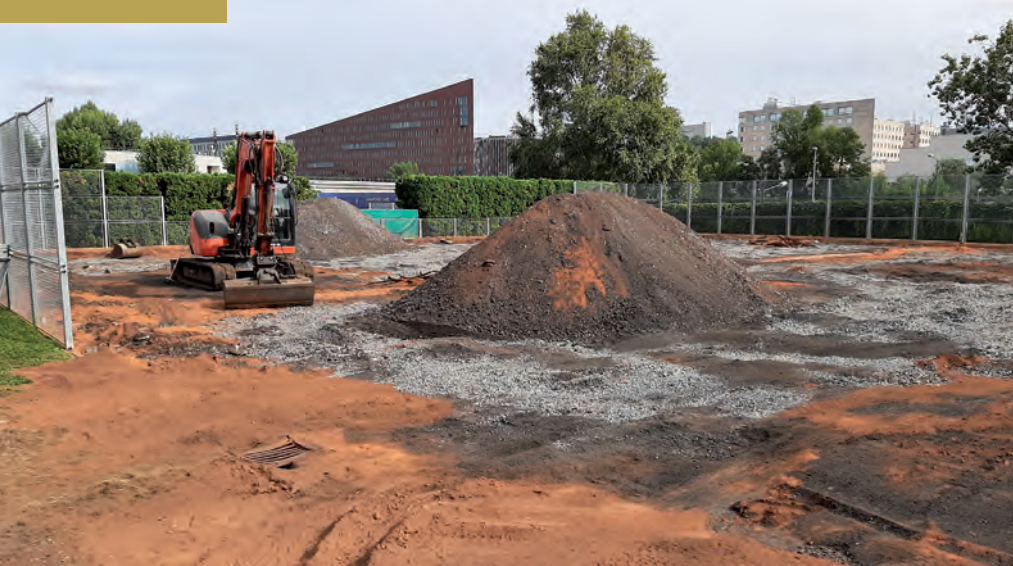
Na začátku rekonstrukce kurtů 7 a 8 to byla tak trochu spoušť
