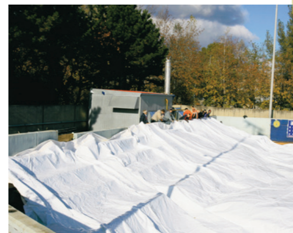
Novou halu bylo třeba nejprve rozprostřít a po obvodu důkladně připevnit. Pak už se »bublina« vyloupla v plné kráse (nahore).
