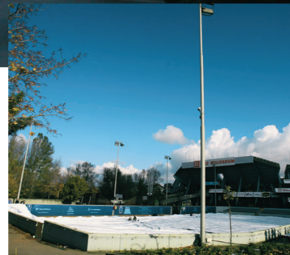
Novou halu bylo třeba nejprve rozprostřít a po obvodu důkladně připevnit. Pak už se »bublina« vyloupla v plné kráse (nahore).
