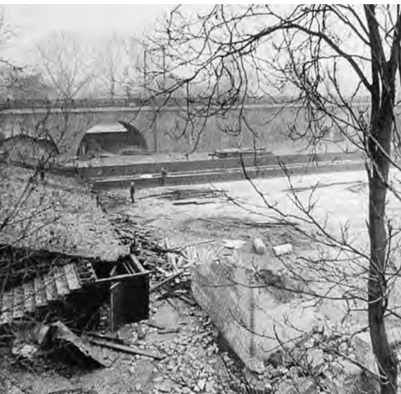
Starý centrkurt před demolicí v roce 1983
