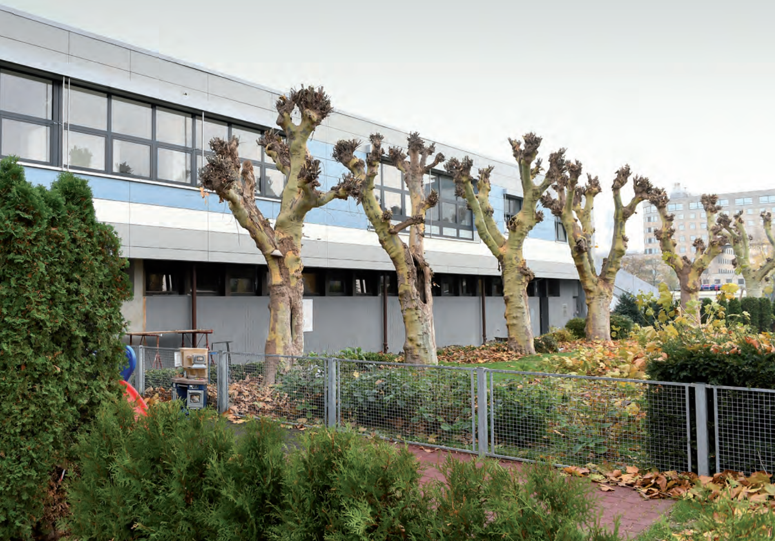
Fasádu přístavby odhalilo až listopadové seřezání větví platanů. Ty budou muset na »holení« častěji než dosud, aby bylo v interiérech dost světla.
