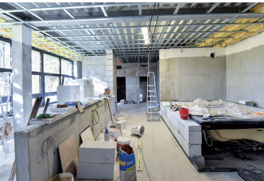
Na konci října bylo ještě ve wellness ryzí staveniště...
