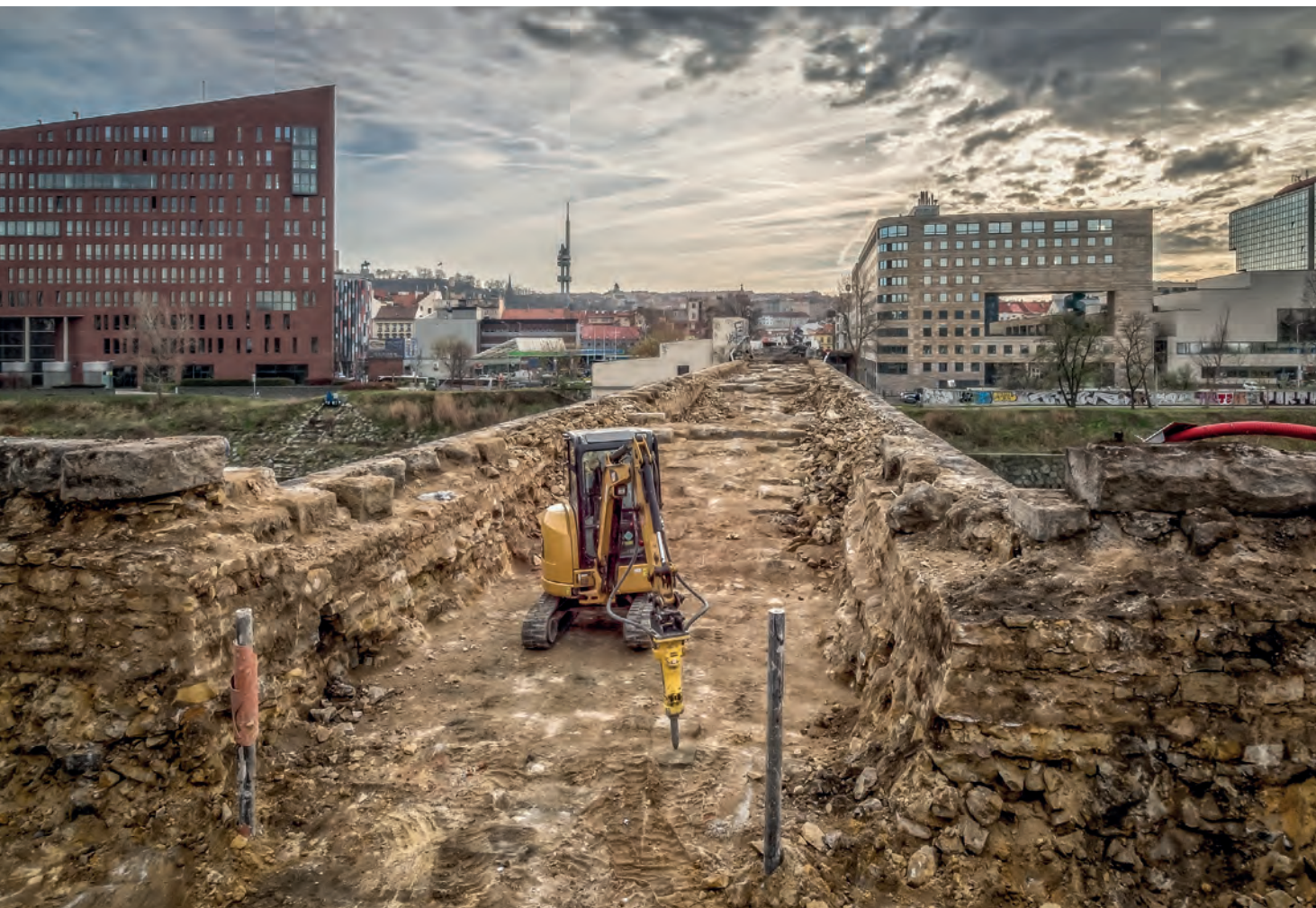
Co se právě děje na viaduktu, to je vidět pouze z ptačí perspektivy. Aktuality o rekonstrukci najdete na www.rekonstrukce-negrelliho-viaduktu.cz .
