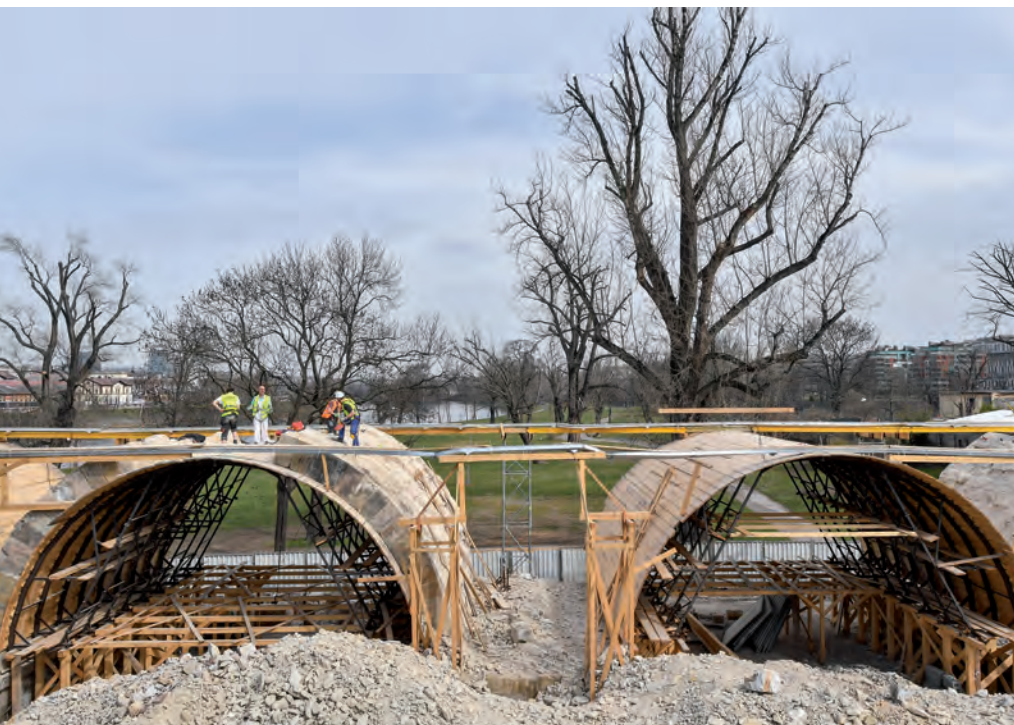
Dva ze čtyř zcela rekonstruovaných oblouků; ten vpravo tvoří aktuálně jen bednění...
