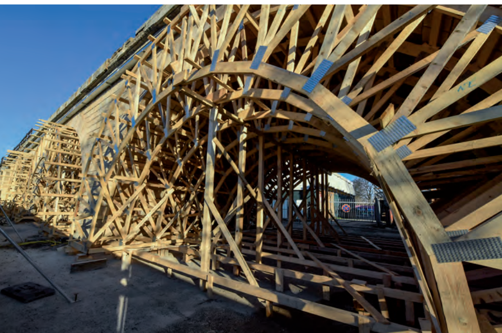
Podskružení oblouků je tesařská lahůdka a vypadá tak trochu jako umělecké dílo
